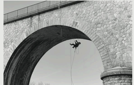
VIADUC DE THOIRAS-LASALLE
