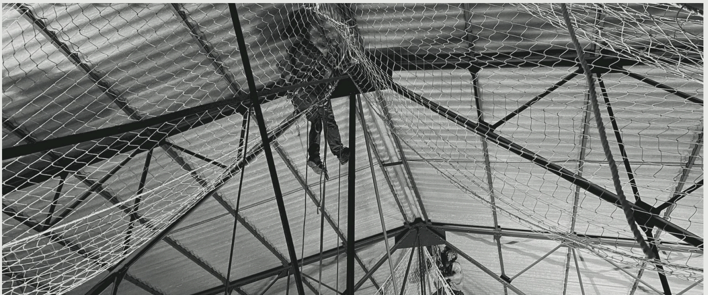
HALLE INDUSTRIELLE • FILETS SOUS TOITURE
